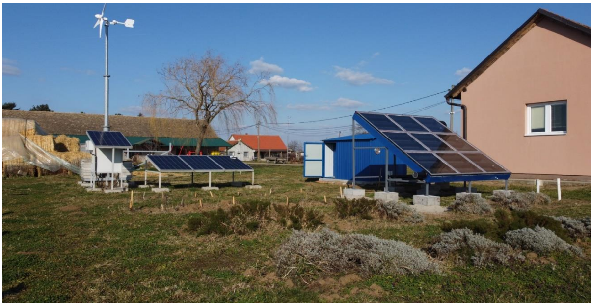
Слика 2. Соларна сушара и помоћно хибридно постројење за производњу енергије на бази сунца и ветра.
