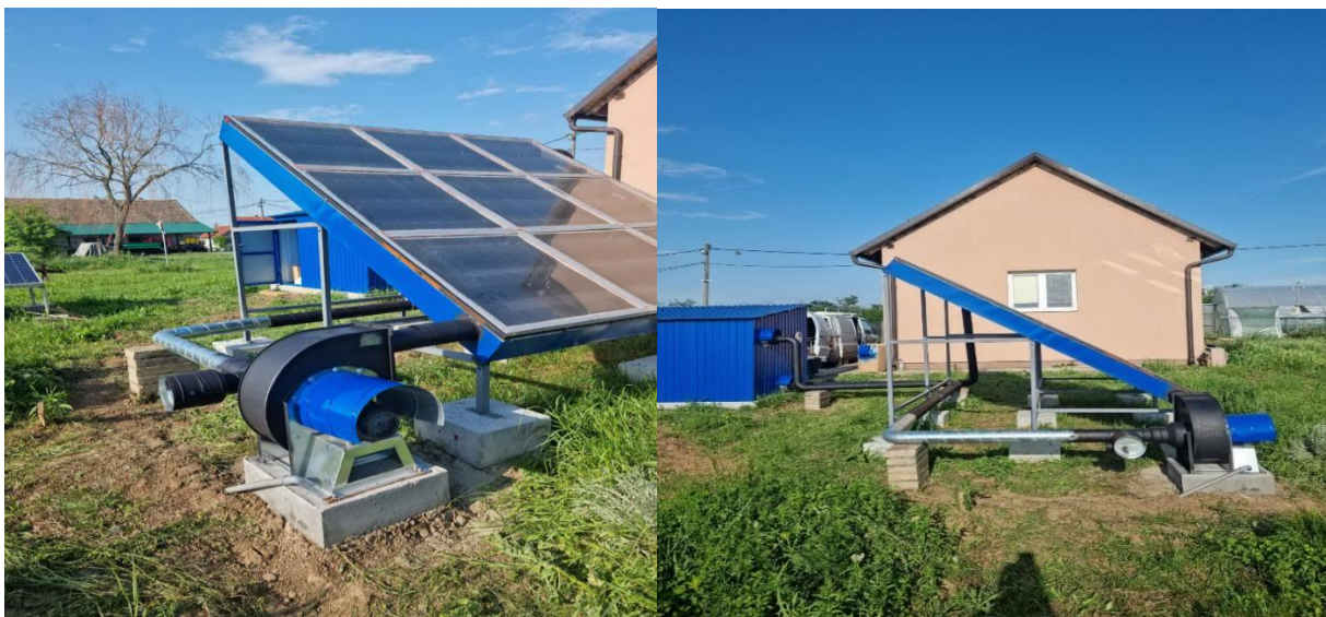
Слика 1. Изглед соларне сушаре с колектором енергије, топлотним складиштем и комором за сушење сировина
